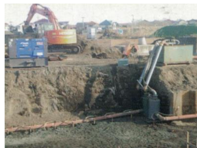
ウェルポイント施工現場
