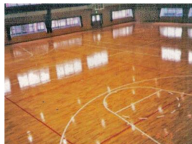
フローリング施工現場
